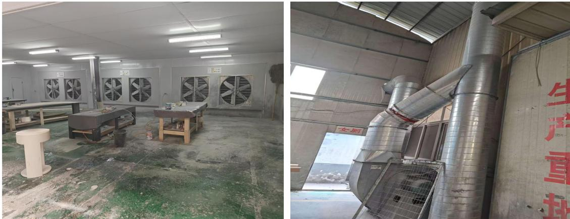
3、喷底漆废气：封闭车间+水帘柜+除湿器+过滤棉+二级活性炭+15m 高排气筒（DA003），现场情况如下：
