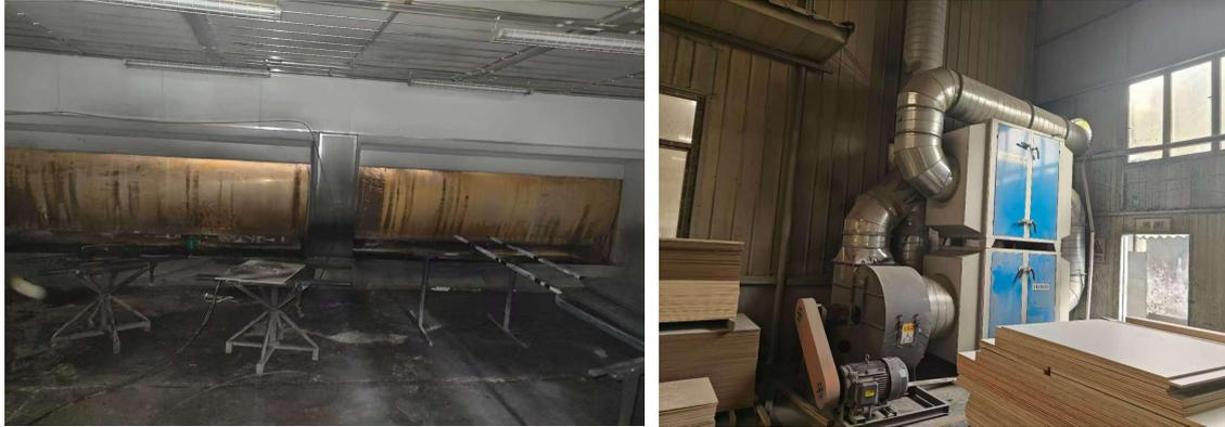
4、喷面漆废气：封闭车间+水帘柜+除湿器+过滤棉+二级活性炭+15m 高排气筒（DA004），现场情况如下：
